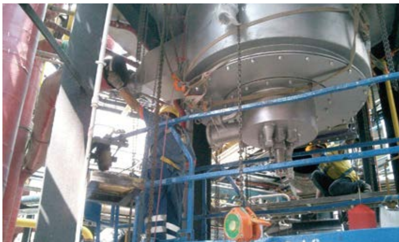
馬頭角廠房-管道接駁
