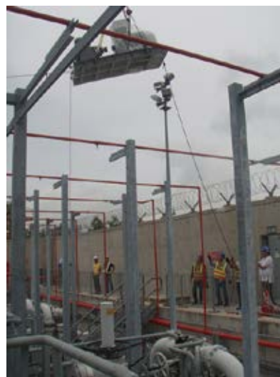
易高航空燃油儲存設施項目—泵吊運
