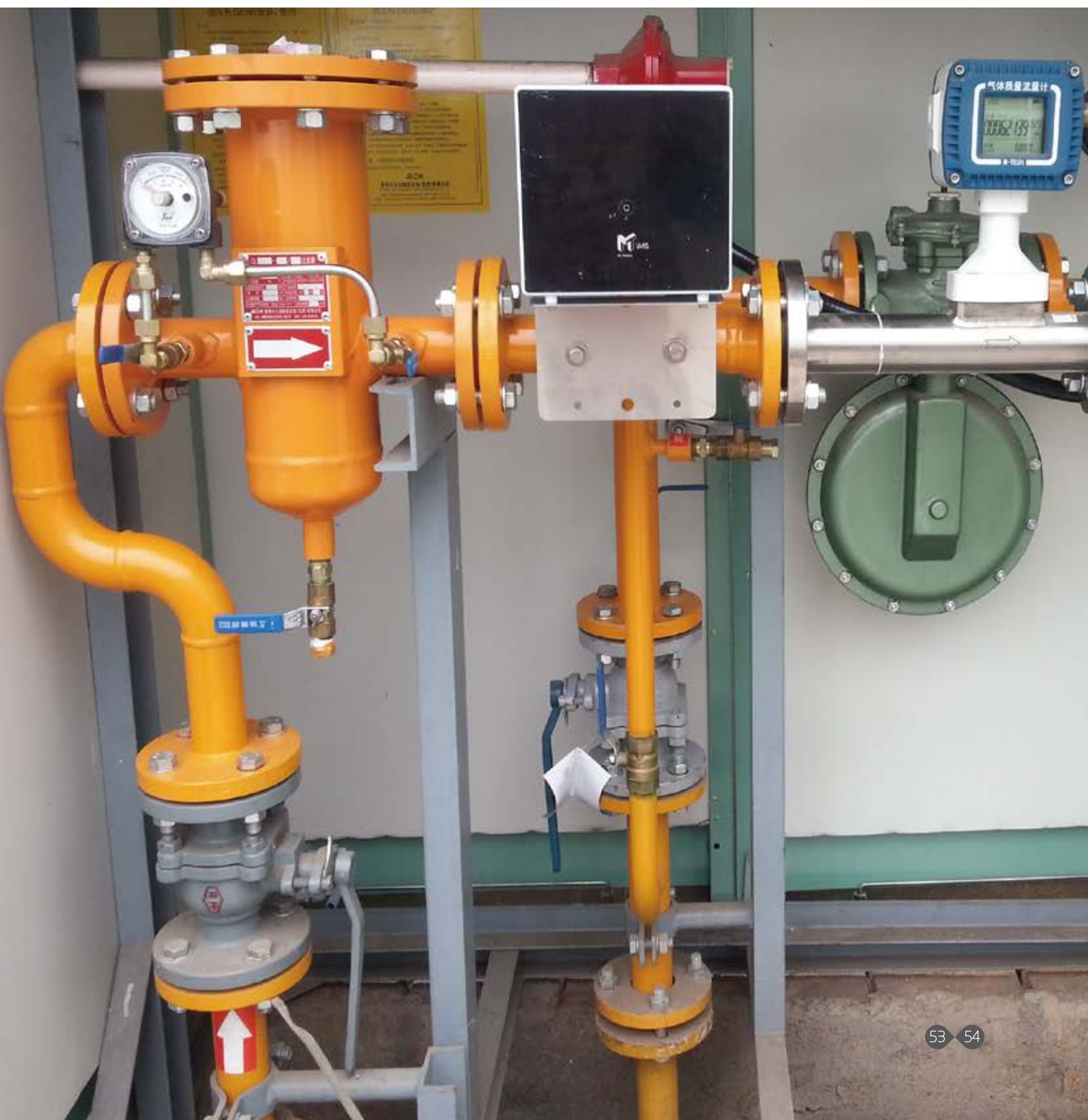
小型戶外計量室安裝卓度IMS控制單元和MEMS工業錶
