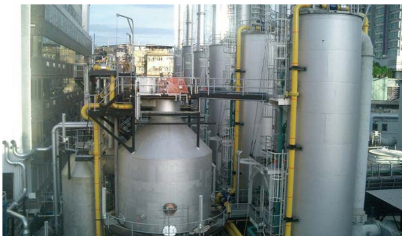
馬頭角廠房-天然氣管道工程
