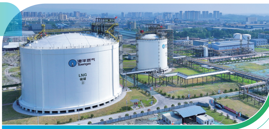
四川威遠儲氣設施。
