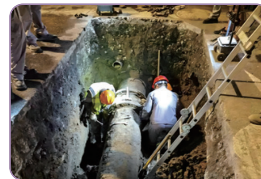
④ 燃氣管線改造施工現場
