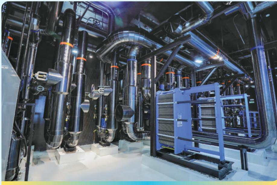
熱源設備可以根據用戶對不同區域和時段的熱能需求、室外溫度傳感器的數據及智慧能源站管理系統，自動調節鍋爐及循環系統的運行模式，以達致按需供能、精準調控的效果，從而大幅節省營運成本。項目的年供熱量約為2.5萬吉焦，能耗水平遠低於同類型項目平均值，每年可減少約750至850噸二氧化碳。
